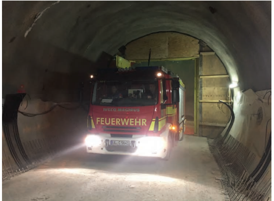
Einfahrt eines Löschgruppenfahrzeugs in eine Tunnelröhre durch eine Wetterwand (Fotos: Feuerwehr Ulm)
