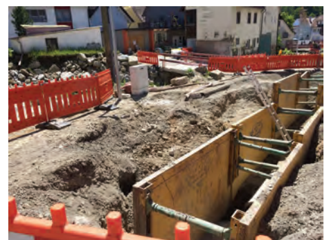
Der Wiederaufbau ist in Braunsbach noch in vollem Gange
